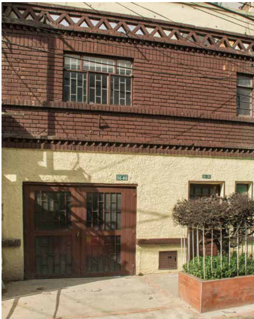
TIPOLOGÍA DE CONSTRUCCIÓN MEDIANERA DE UNO Y DOS PISOS CON FRENTE ANGOSTO SIN LOCAL COMERCIAL FOTOGRAFÍAS: 2020. CAMILO RODRÍGUEZ-IDPC
