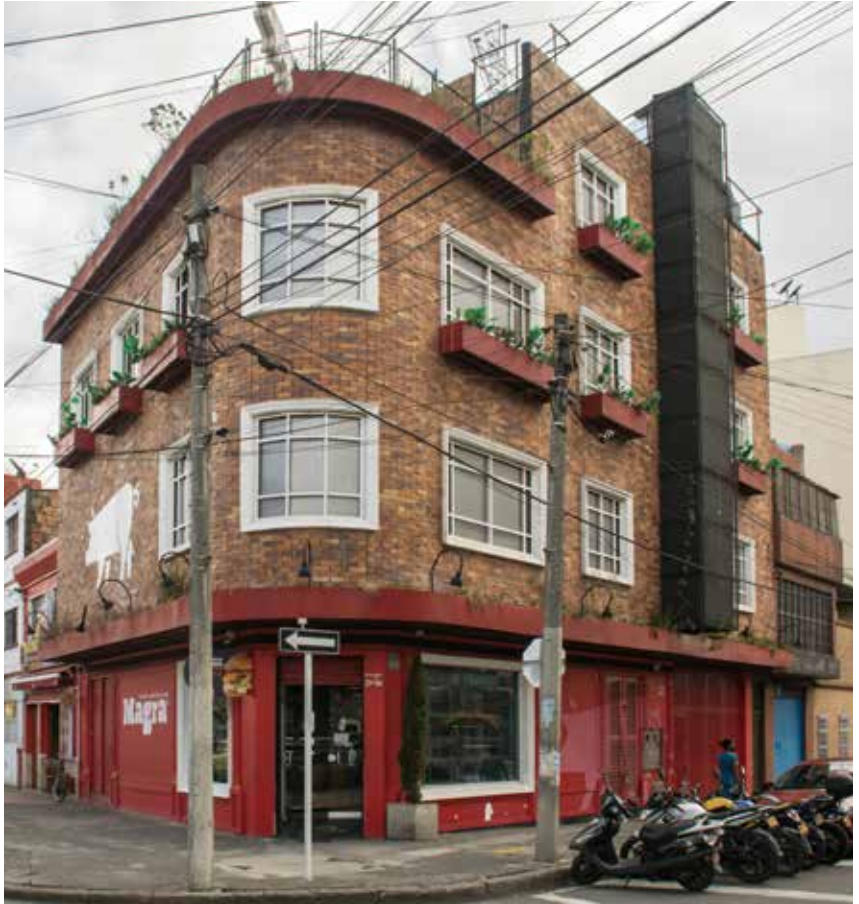
ESTADO ACTUAL DE BARRIO EN LA CARRERA 56 CON CALLE 79B. 2019 FOTOGRAFÍA: CAMILO RODRÍGUEZ-IDPC
