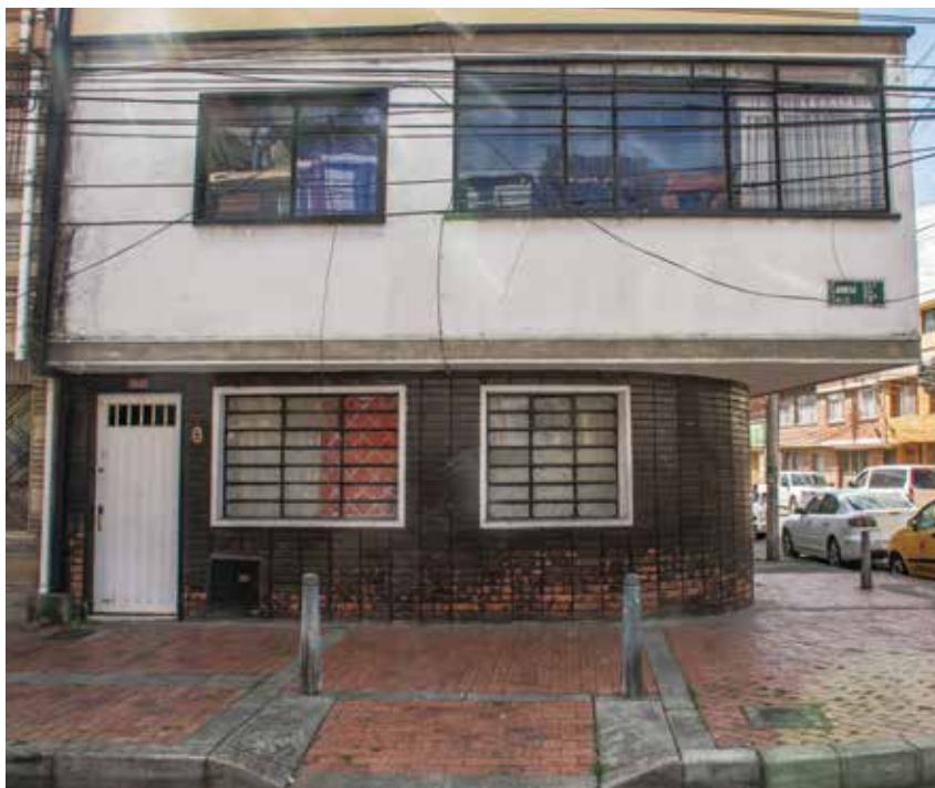
TIPOLOGÍA DE CONSTRUCCIÓN ESQUINERA DE DOS PISOS SIN LOCAL COMERCIAL. 2019 FUENTE: ALZADO POR MIEMBROS DEL EQUIPO DE LA AGRUPACIÓN DMB-OLC-WAP Y FOTOGRAFÍA 2020. CAMILO RODRÍGUEZ-IDPC
