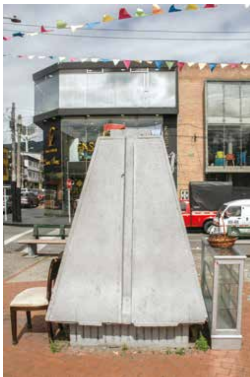
ESTADO ACTUAL DEL MONUMENTO A MANUELA AYALA DE GAITÁN FUENTE: FOTOGRAFÍA DEL EQUIPO DE TRABAJO, AGOSTO DE 2019.
