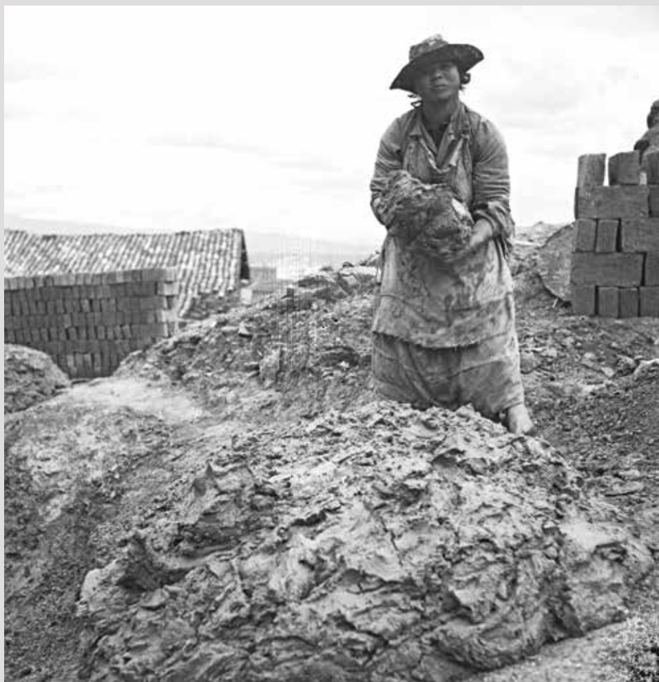
[PRENSADO MANUAL DE LADRILLOS, CHIRCALES SUR DE BOGOTÁ]. 1938. FONDO DANIEL RODRÍGUEZ, COLECCIÓN MUSEO DE BOGOTÁ
