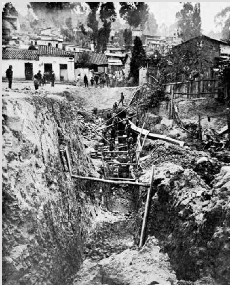
CONSTRUCCIÓN DEL ALCANTARILLADO DE LA PLAZUELA DE CHIQUEQUIRÁ, CA. 1938. SOCIEDAD DE MEJORAS Y ORNATO DE BOGOTÁ
