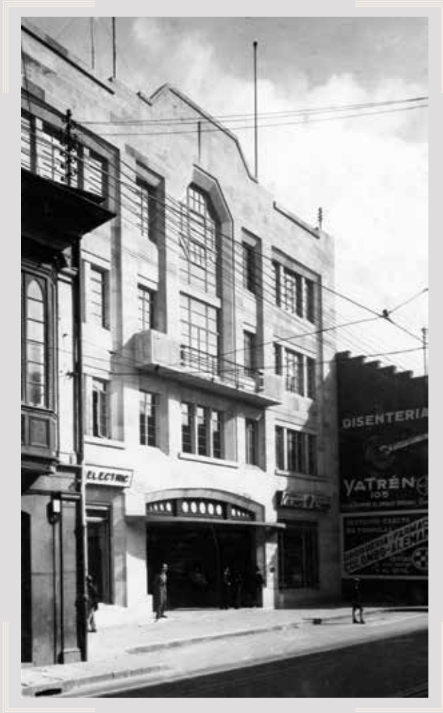
EDIFICIO CÓRDOBA / URIGAR. 1938. SOCIEDAD DE MEJORAS Y ORNATO DE BOGOTÁ.
