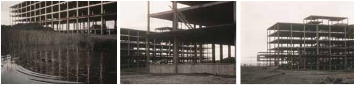
{ESCENAS DE UN EDIFICIO EN CONSTRUCCIÓN EN RAPSODIA EN BOGOTÁ, 1963.}
