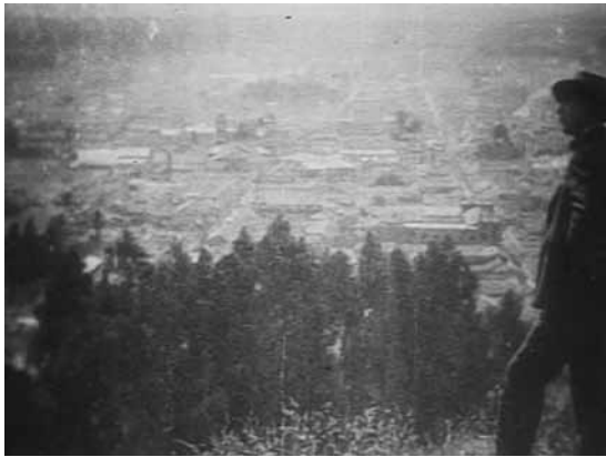
(ESCENAS DE ALMA PROVINCIANA DONDE GERARDO CONTEMPLA LA CIUDAD DESDE LOS CERROS ORIENTALES. SE ALCANZA A OBSERVAR MUY BORROSAMENTE LA CÚPULA DEL DESAPARECIDO CONVENTO DE SANTO DOMINGO, EL SEMINARIO MENOR –HOY CONJUNTO RESIDENCIAL CALLE DEL SOL– Y LAS TORRES DE LA CATEDRAL PRIMADA, 1926.)
