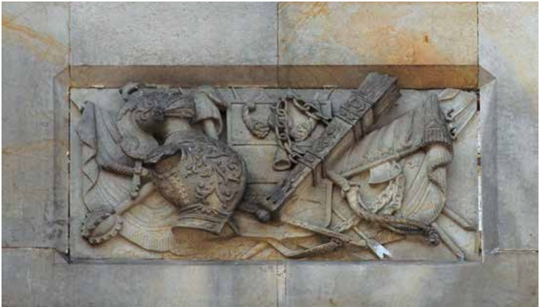
Mario Lambardi (atribuido). Relieves en la fachada del Capitolio realizados hacia 1880 . 2018. ¿Piedra de Balsillas? Foto: Carlos Lema-IDPC
