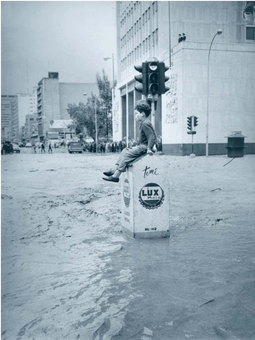
Desbordamiento del Río San Francisco. 1968.
