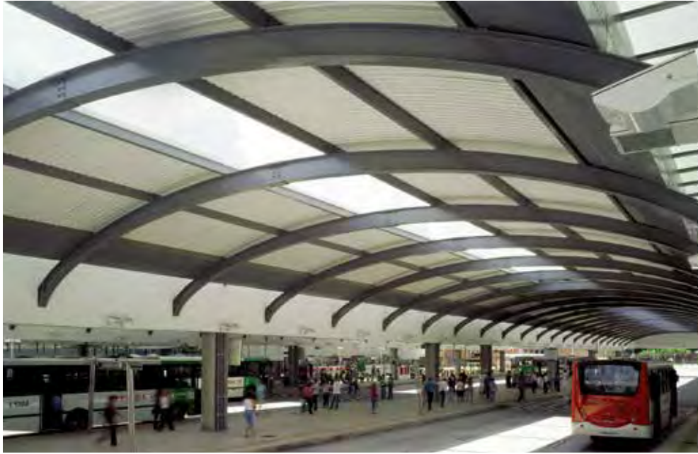
Plataformas. Fotografía: Nelson Kon
