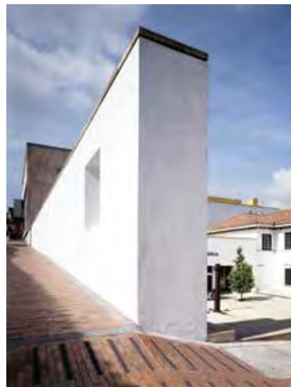
> Muro que da continuidad a la carrera 4ª. Fotografía: Pablo Rojas
