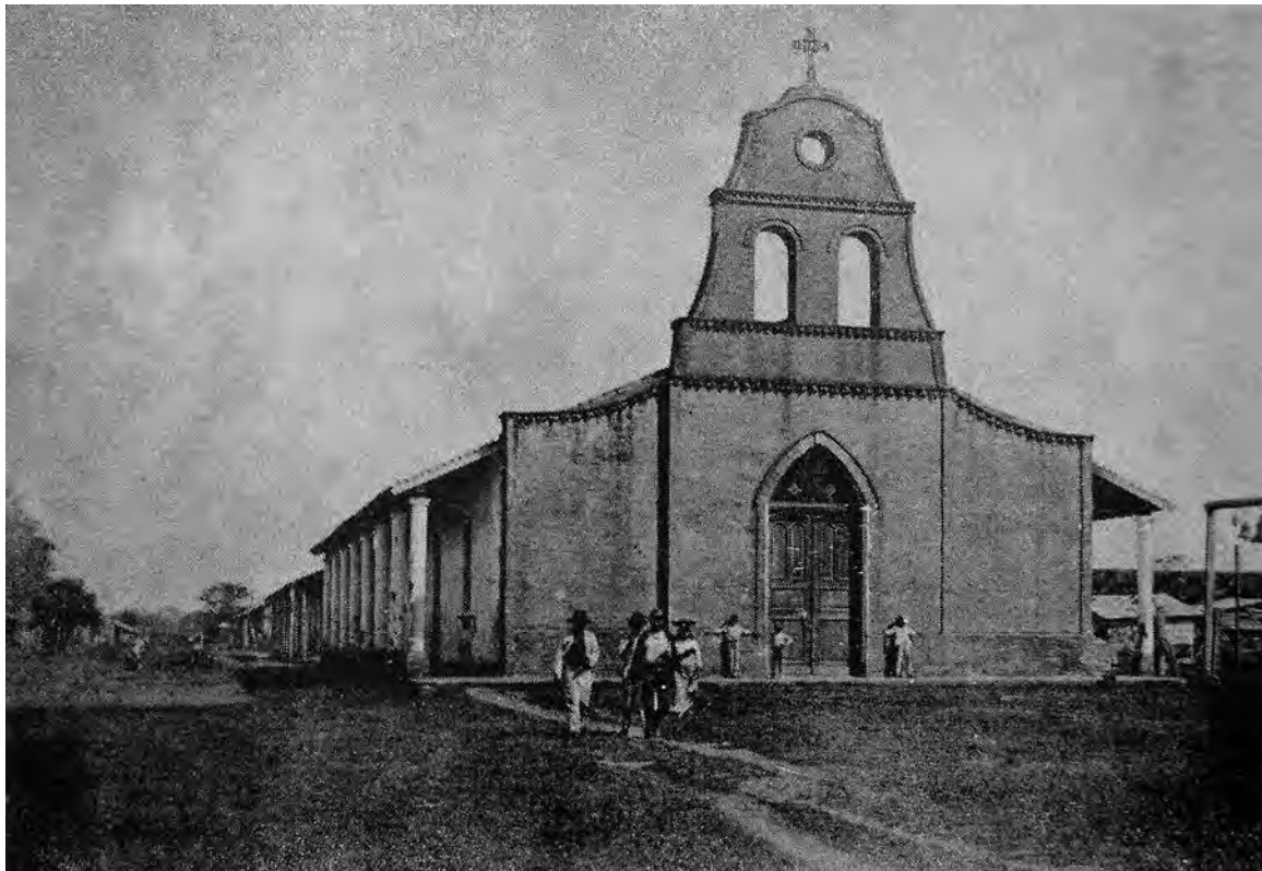
La catedral en 1914. Archivo: Aparicio Arquitectura + Construcción
