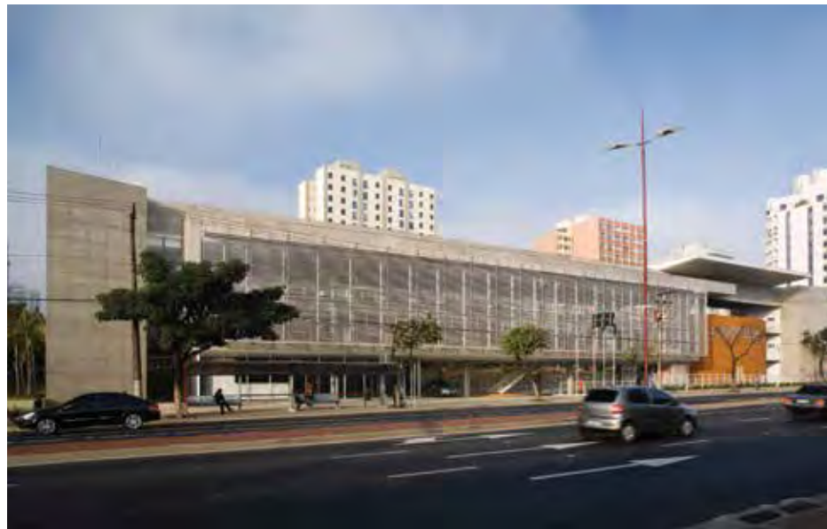
Fachada hacia la avenida Goiás. Fotografía: Nelson Kon
