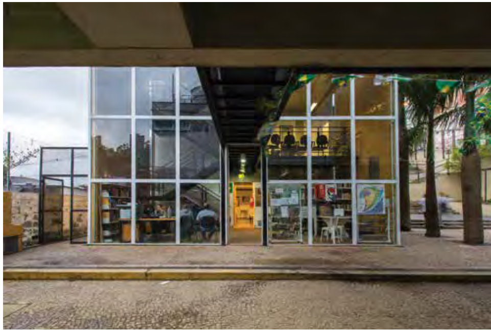
Plaza cubierta y al fondo la cancha de basquetbol. Fotografía: Priscila Amaral
