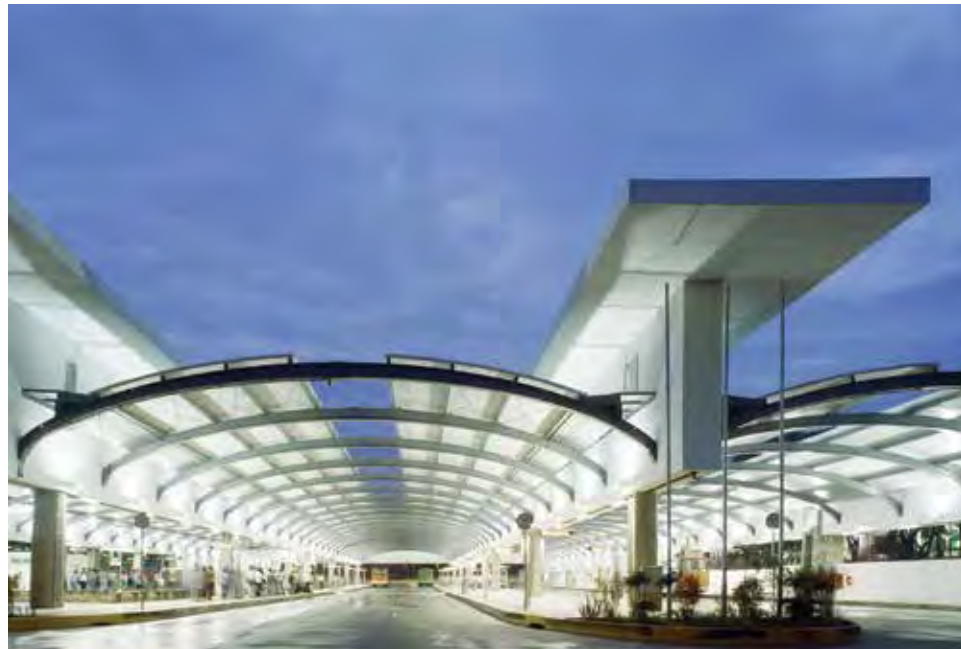
Plataformas. Fotografía: Nelson Kon
