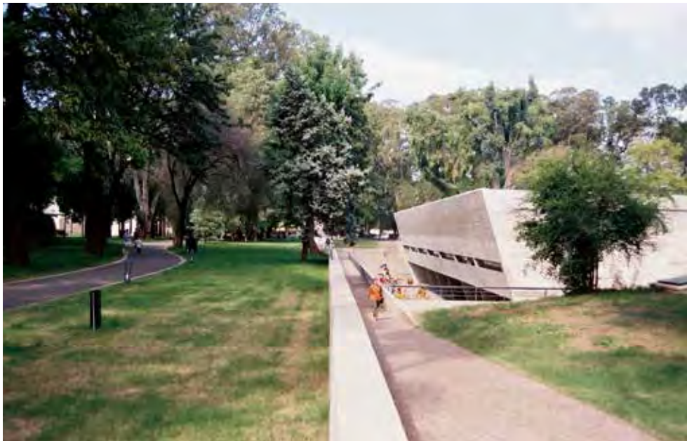
Rampa hacia la edificación. Fotografía: Luis Vignoli Blotta
