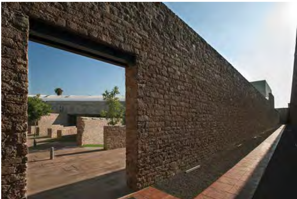
Pasillo perimetral y acceso a patios. Fotografía: Jaime Navarro Soto
