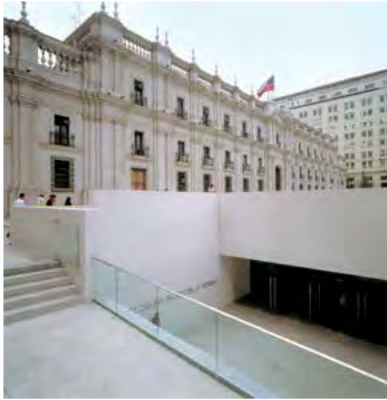
Acceso al Centro Cultural, construido bajo la Plaza. Fotografía: archivo Undurraga + Devés
