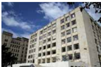
| EDIFICIO MURILLO TORO. Foto MUG
